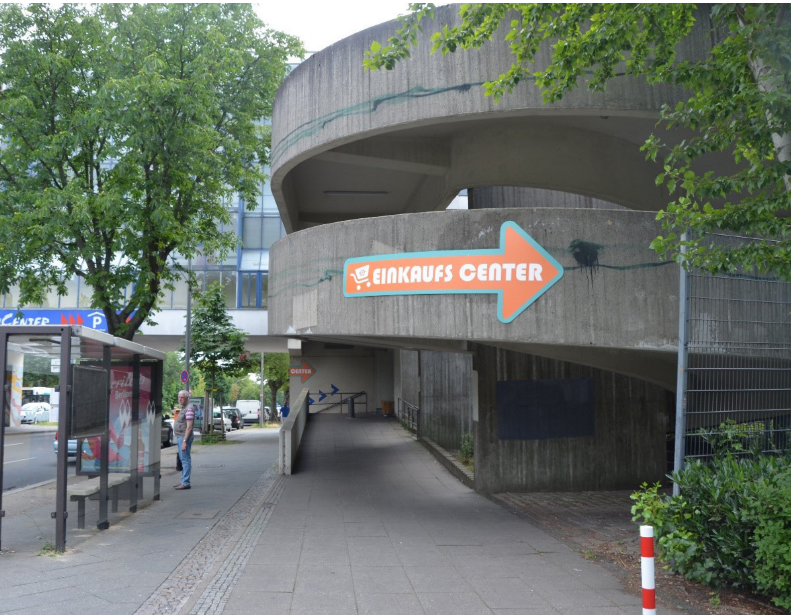
Abbildung 8: Verschattung und mangelnde Einsehbarkeiten unter Fußgängerbrücken in der High-Deck-Siedlung in Berlin-Neukölln. © Weeber+Partner, Juni 2020
